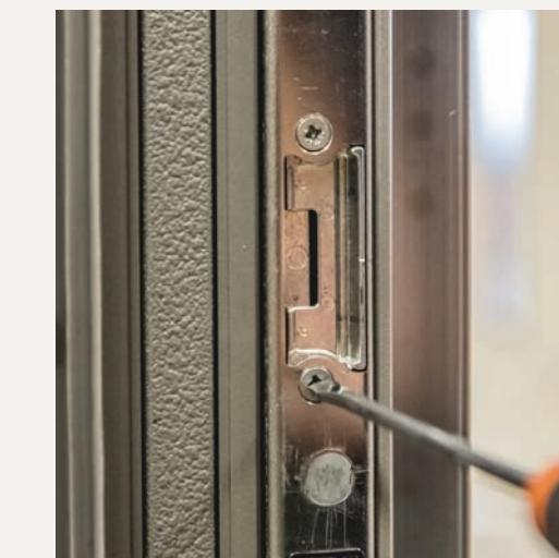
In lega metallica ad alta resistenza collocato su un profilato di acciaio zincato, si regola a porta aperta permettendo così l'accostamento dell'anta al telaio secondo necessità.
